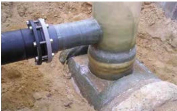
Leveren en herstellen van glasvezelversterkt leidingwerk..
