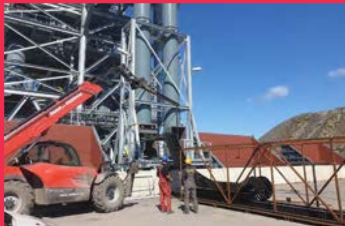
Grote montageprojecten tijdens geplande stilstanden : golfbandbanden vervangen, staalkabelbanden vervangen, etc.
