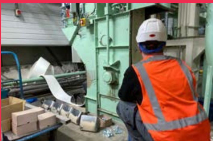
Vervangen van elevatorbanden.
