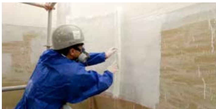
Herstellen en bekleden van tanks en calamiteiten-bakken met glasvezelversterkte polyester en vinylester.
