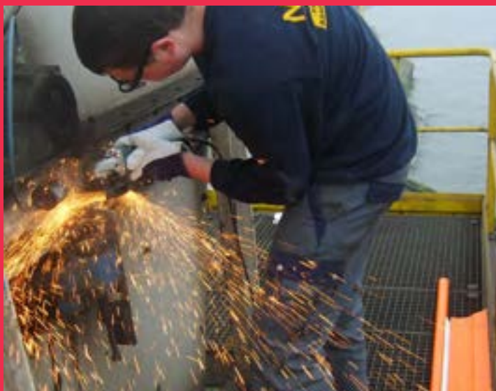
Mechanische werken : afschrapers monteren
