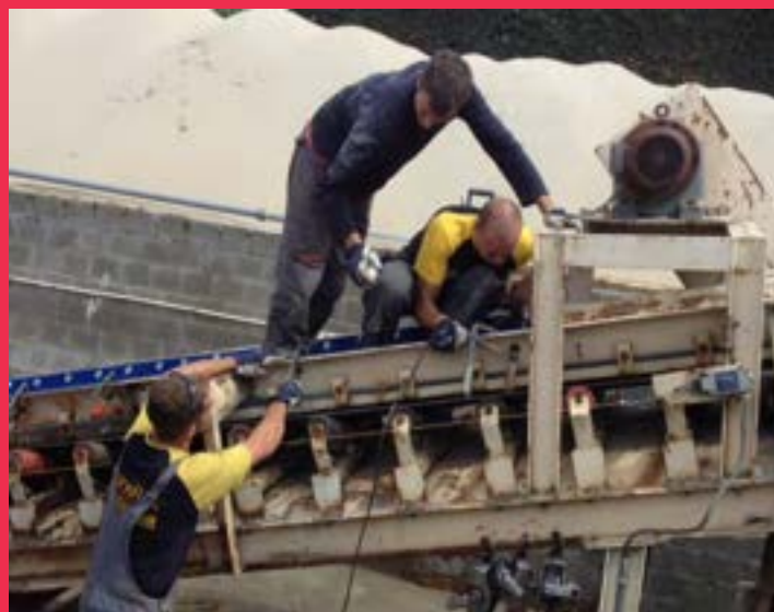
Mechanische werken: aanpassen stortpunten
