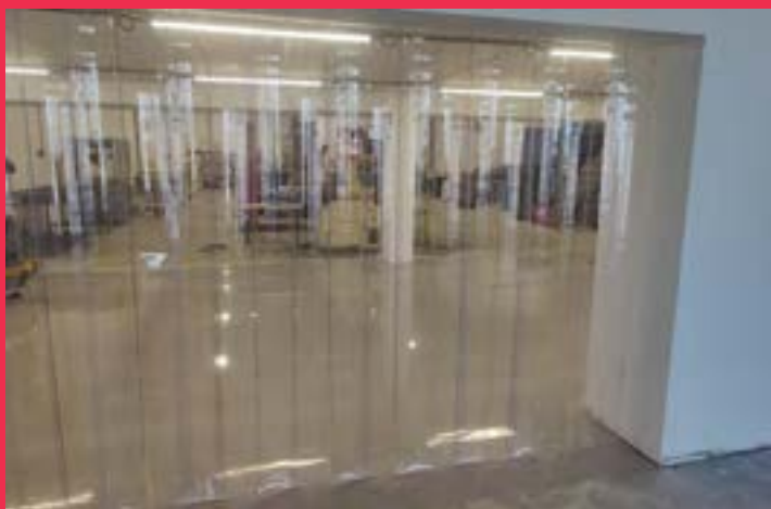
Leveren en monteren van tochtstrips en ophangsystemen.
