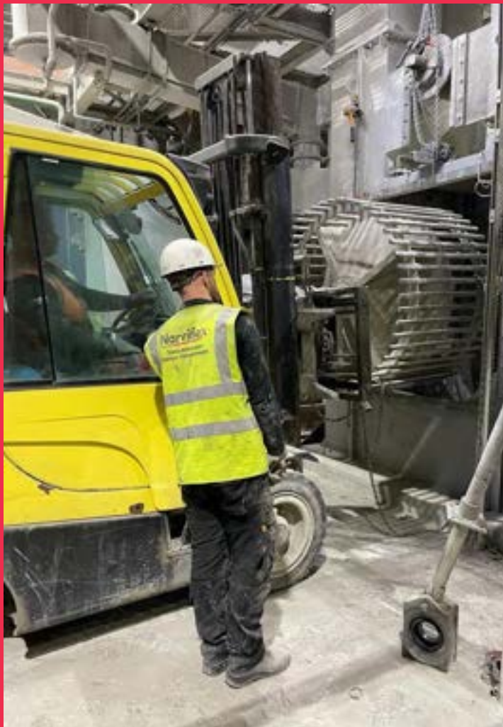
Rollen vervangen, trommels vervangen, afschrapers afstellen, etc.
