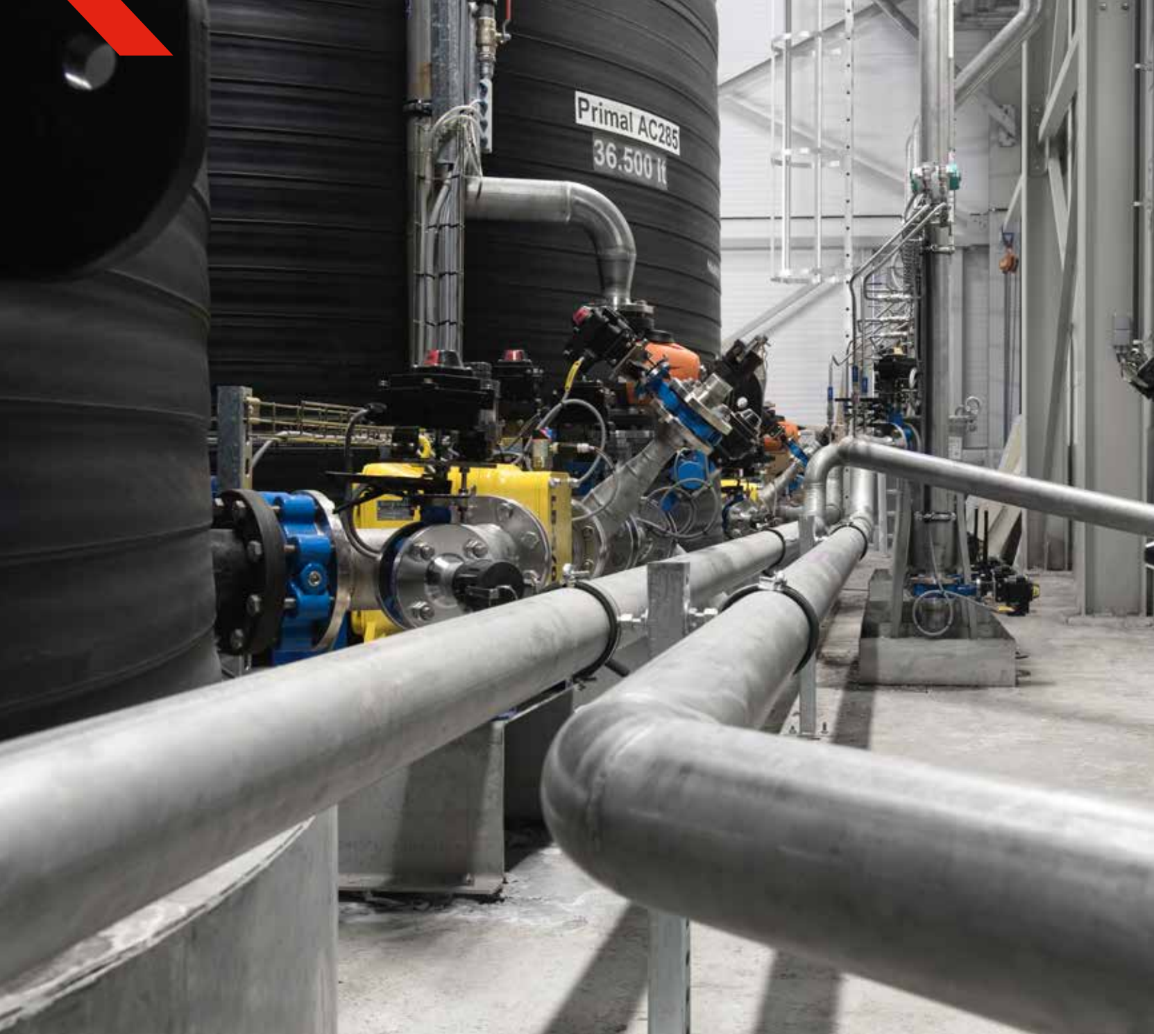
Boss Paint: RVS piping en pompen
