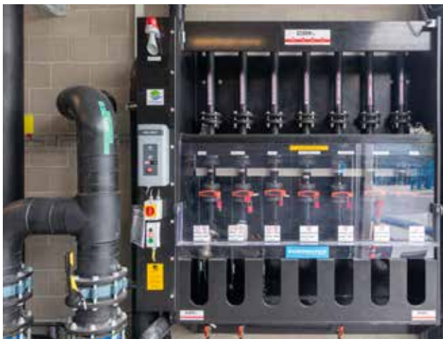
Alpro: vulkast volledig op maat gemaakt met specifieke vulpunten en afmetingen
