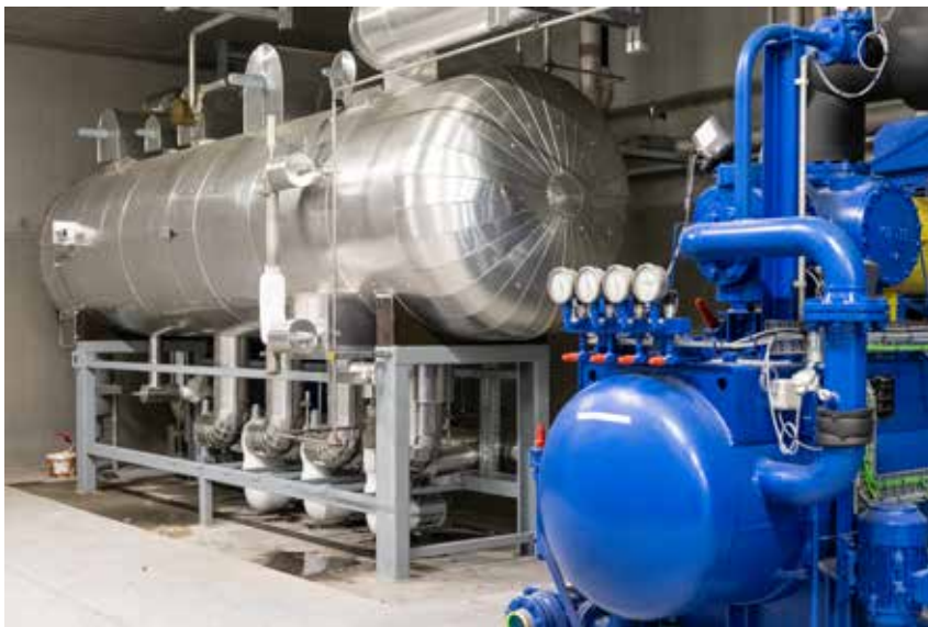
De Coster: isolatie van een koelinstallatie
