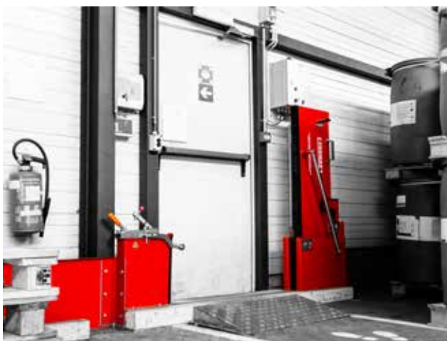
GCP: halfautomatische vloeistofbarrière voor de inkuiping van ontvlambare stoffen
