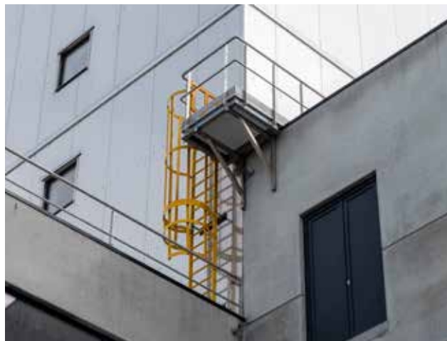
Zoutman: kooiladder en loopbrug in GVK
