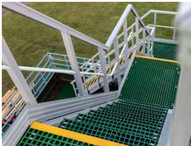
WPC De Gavers: GVK trap voor gebruik rond tanks
