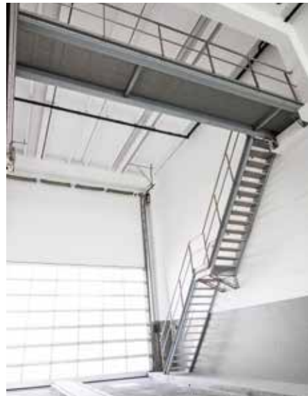
Zoutman: kooiladder en loopbrug in GVK
