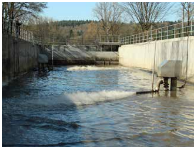
Jetreiniger tegen slibvorming in afvalwaterbassins
