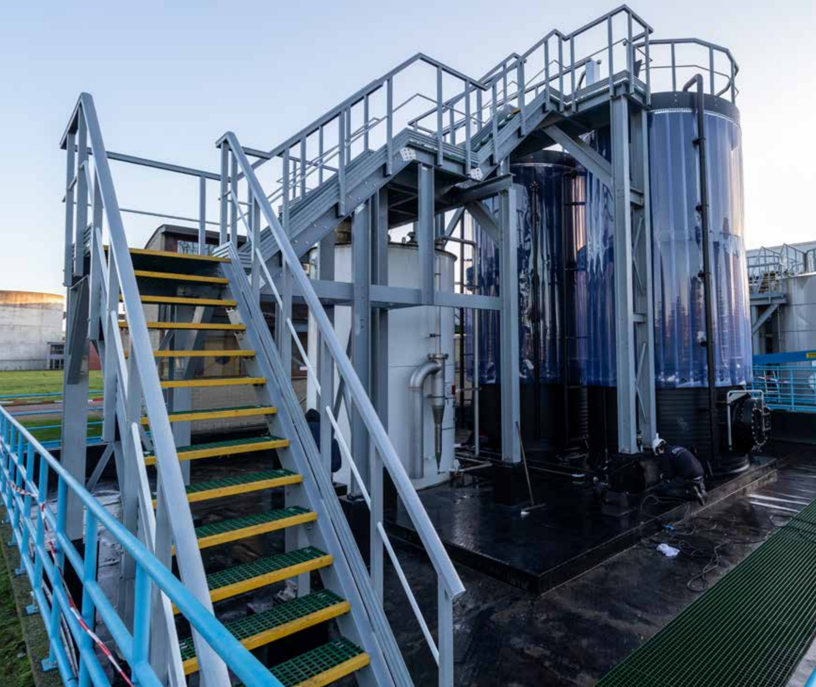
WPC De Gavers: GVK structuren & bordessen voor gebruik rond tanks
