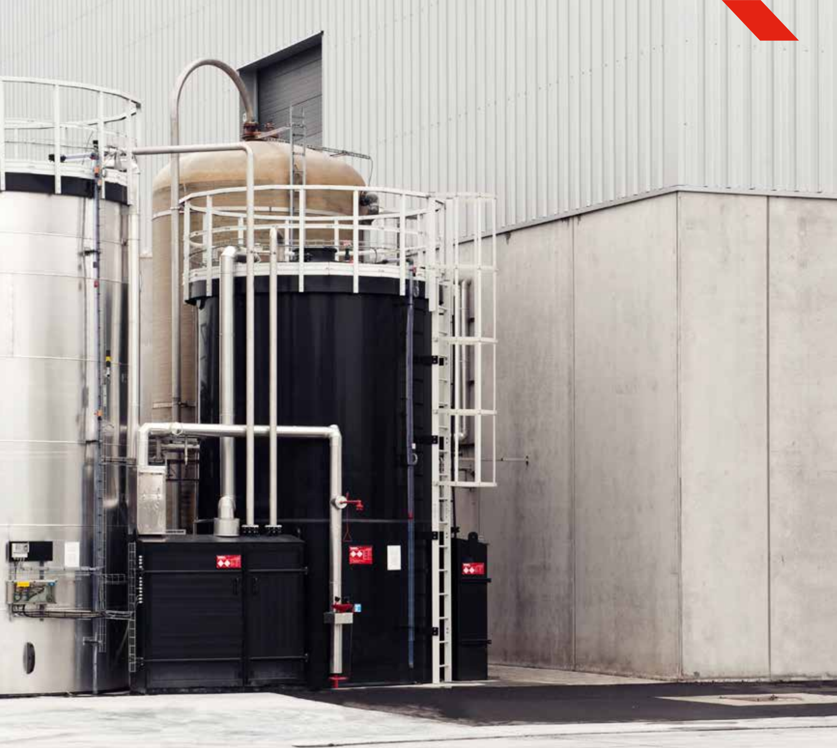
Cosucra: dubbelwandige opslagtanks voor NaOH met mengkast en met GVK bordessen en kooiladder
