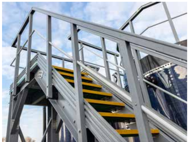
WPC De Gavers: GVK trap voor gebruik rond tanks
