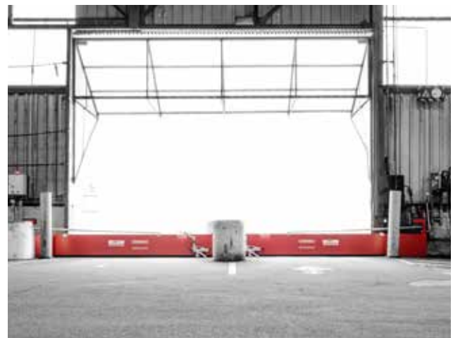
Brenntag: dubbele half-automatische barrière voor het vloeistofdicht maken van hun gebouw
