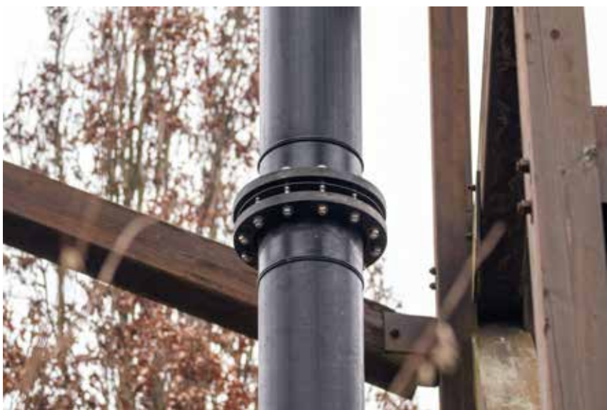
Bellewaerde: vervanging van hoofdwaterleiding in kunststof van Niagara splash
