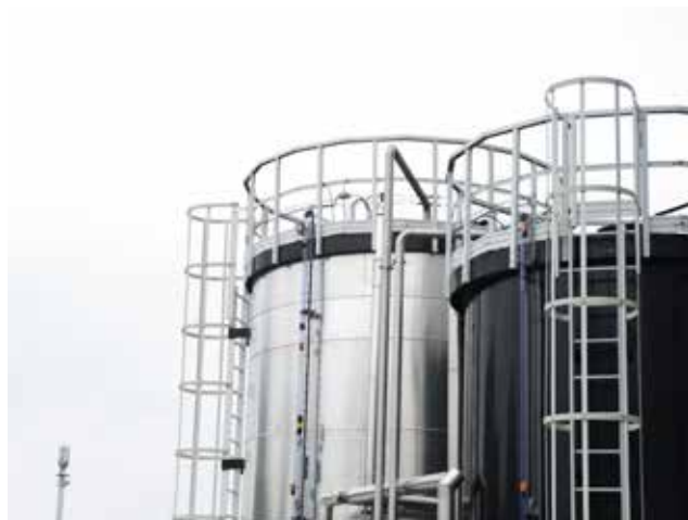
Cosucra: GVK kooiladders en bordessen voor 2 dubbelwandige kunststof tanks
