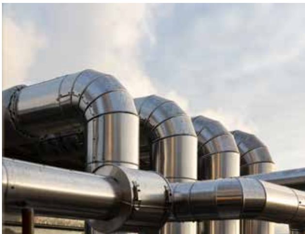
Dynea: isolatiewerken voor stoom en condens van leidingen en een reactor waarin lijm zit
