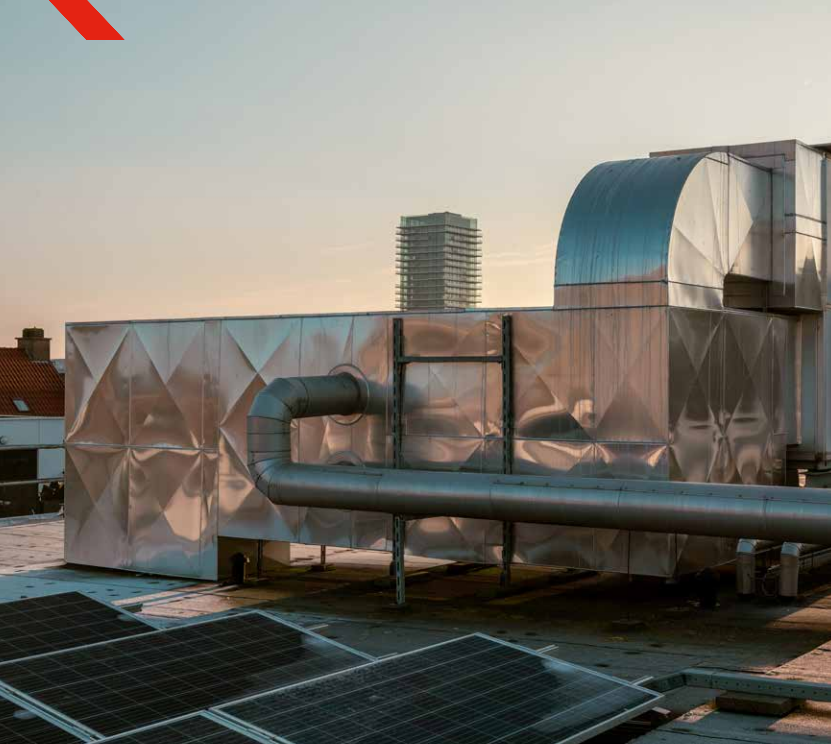
De Groeiboom: isolatie van ventilatiekanalen met extra supporterings tegen de wind
