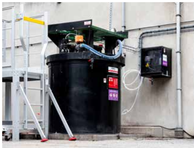
Alco Biofuel: moeder-dochtertank om gecontroleerd FeCl 3 toe te voegen aan de watertank
